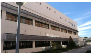
EDIFICIO GRUPO GMV
